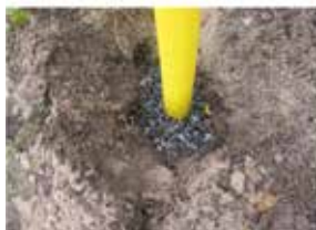
3. Återfyll med grusmaterial
