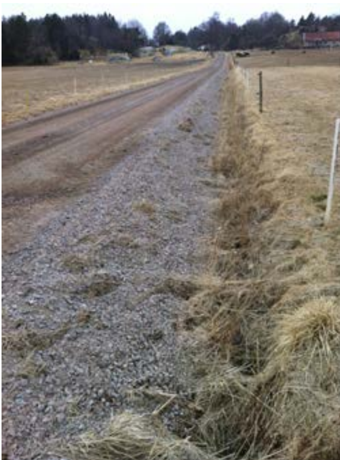
Slitlagergrus som är nerplogat i diket.
