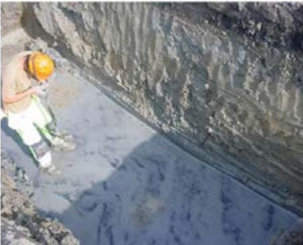
En typisk gråblå postglacial lera som bildades i havet under landhöjningen. På bilden framkommer den i schaktbotten på en grop i Västerås och har mörka ränder efter sulfidutfällningar på en tidigare syrefri havsbotten. Foto: Magnus Hellqvist
