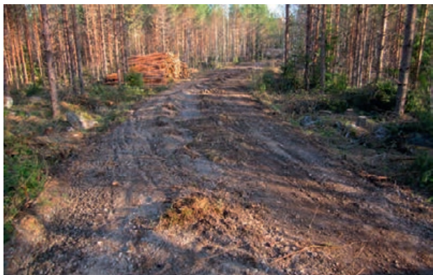
Kantskuren skogsbilväg före fräsning av vägytan.
