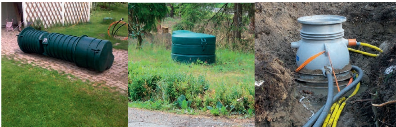
Två typer av pumpenheter för tryckavlopp. De är ca 2,5 meter höga men det mesta ska grävas ner under jord.
