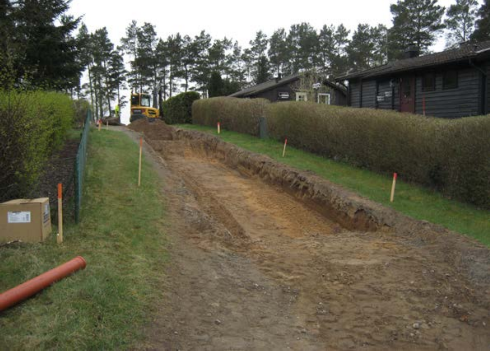
Schaktning i sandjord. Sand är normalt en stabil och vattengenomsläpplig jordart, vilket är positivt för en väg. Däremot kan ytvatten lätt erodera sig ner i sanden. Foto: Lars Olin
