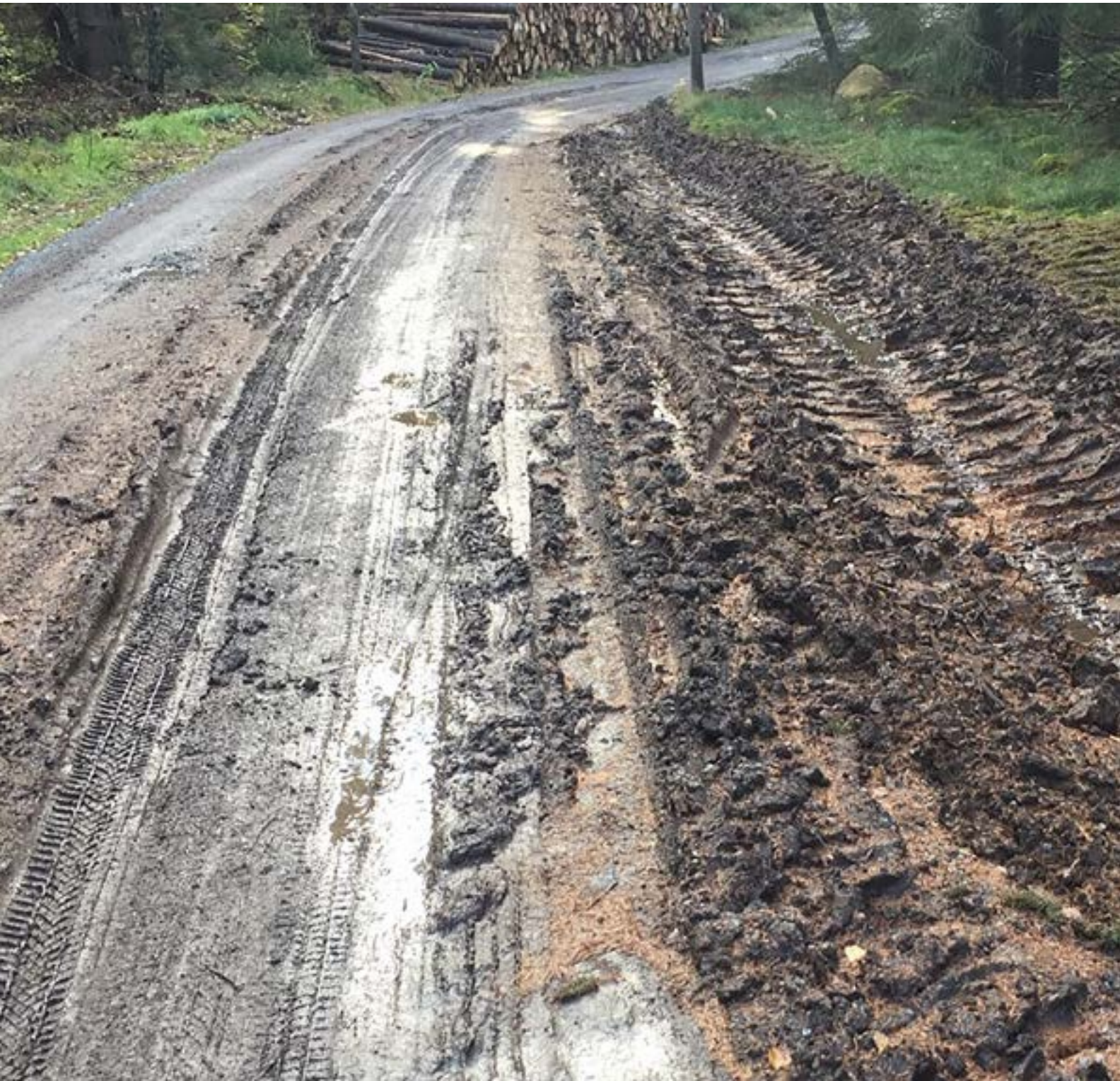
Blöt och vattenmättad jord, speciellt med mycket silt- och lerpartiklar, skapar lätt skador vid stor belastning. Foto: Lars Hillman
