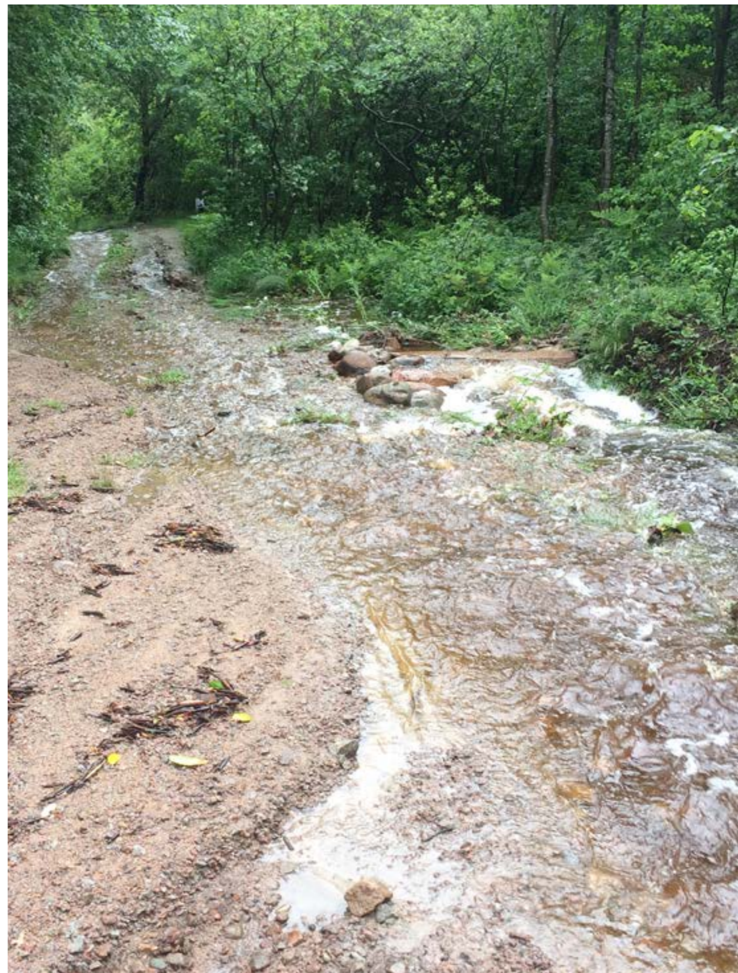
En igensatt trumma kan göra så att vattnet tar annan väg och orsakar skador.
